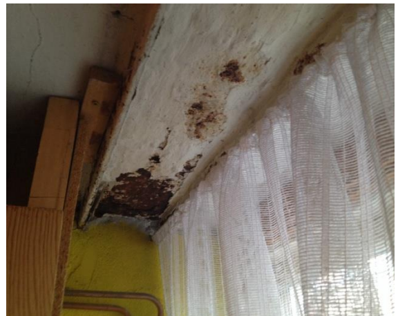
| Bærende bjælke over kældervindue.
