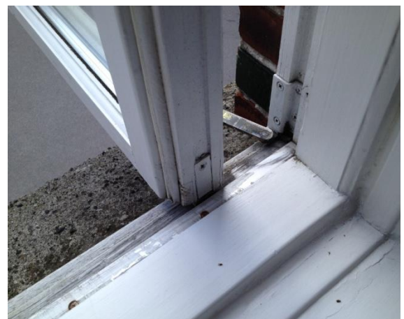
| Glideskinner der sidder løst og kører meget stramt.
