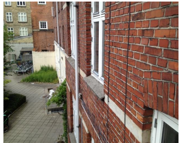
| Arbejdet skal udføres fra stillads.
