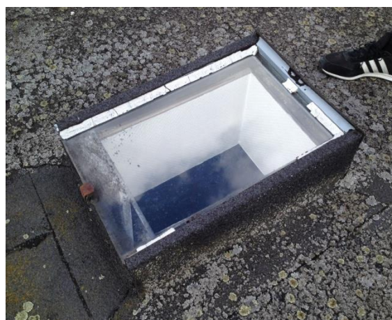
| Elendige ovenlys – disse alene gør at man med fordel kunne skifte taget allerede i dag!
