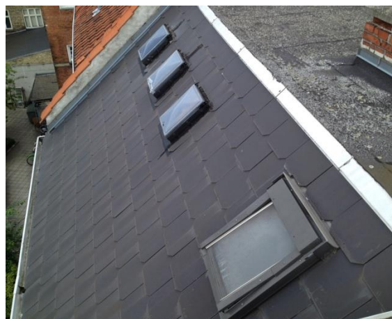
| Det er denne tagside ind mod gården, som skal bygges helt om.
